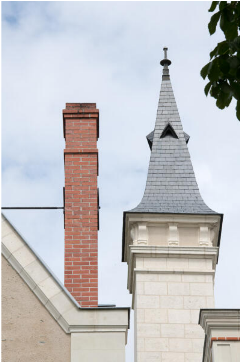
Détail du lanternon surmontant la tour d'escalier.
