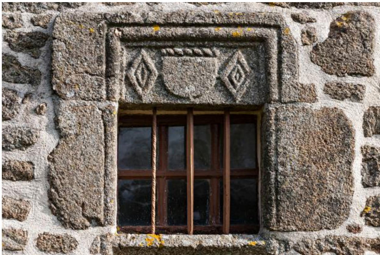
Demi-croisée de la façade sud, linteau orné d'un écu et de deux losanges.
