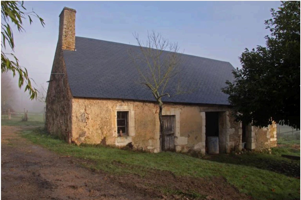
Maison étudiée (désaffectée), vue de volume.
