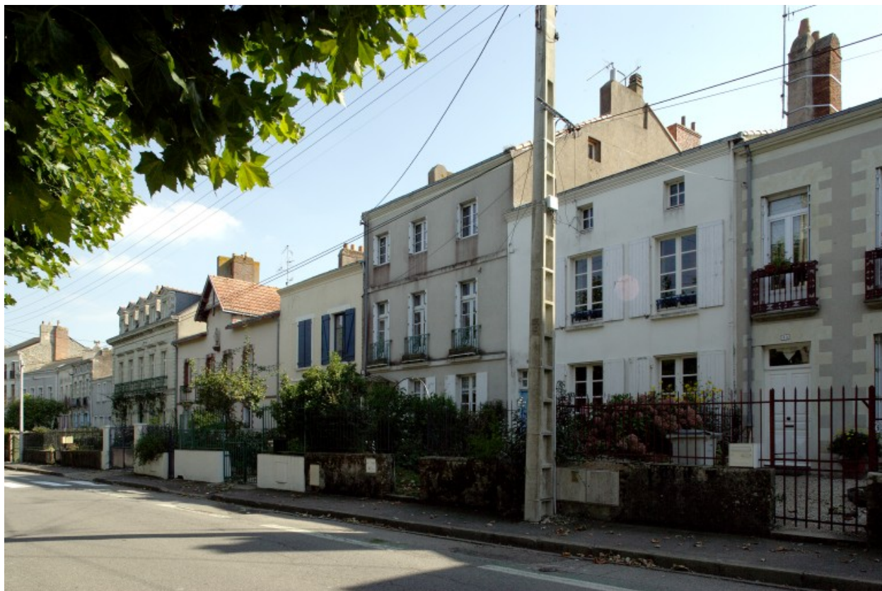
Vue d'ensemble du n° 23 au n° 32, quai Eole.
