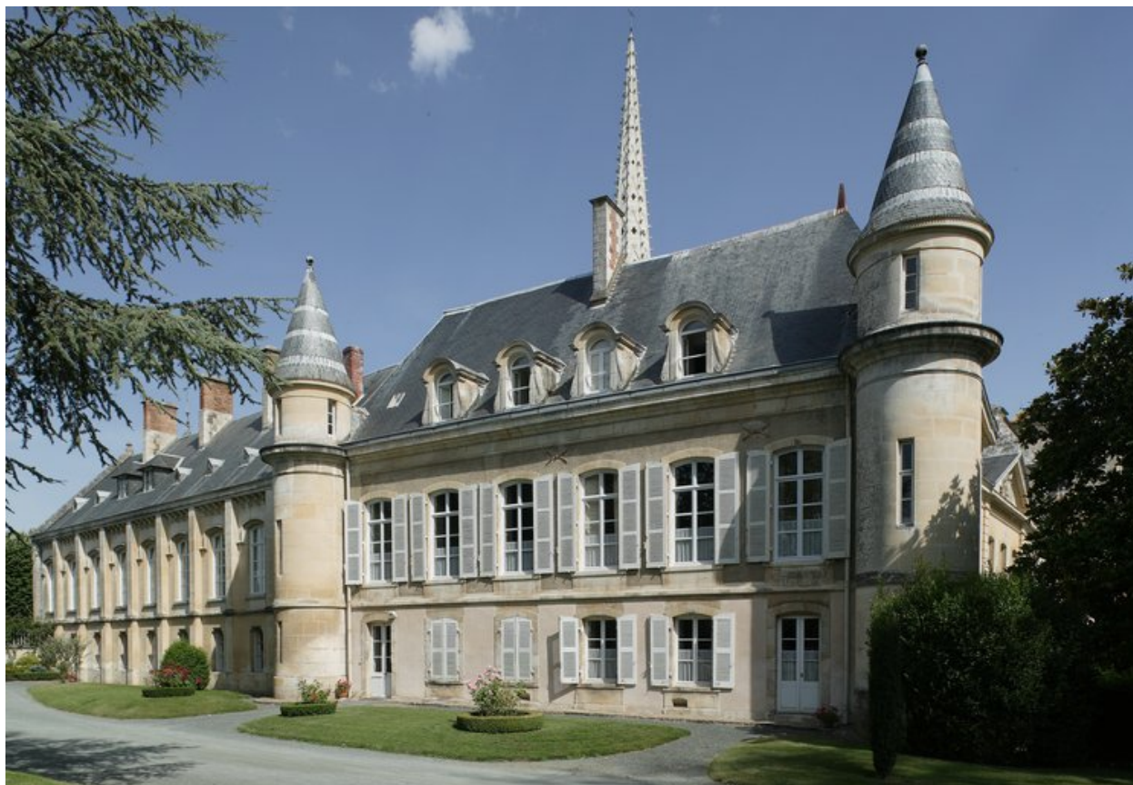
Vue d'ensemble du bâtiment sud, prise du sud-est.
