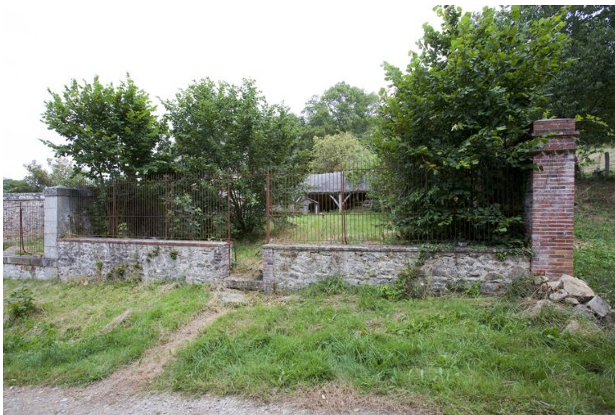
L'enclos haut (potager?) : vue d'ensemble depuis le sud.
