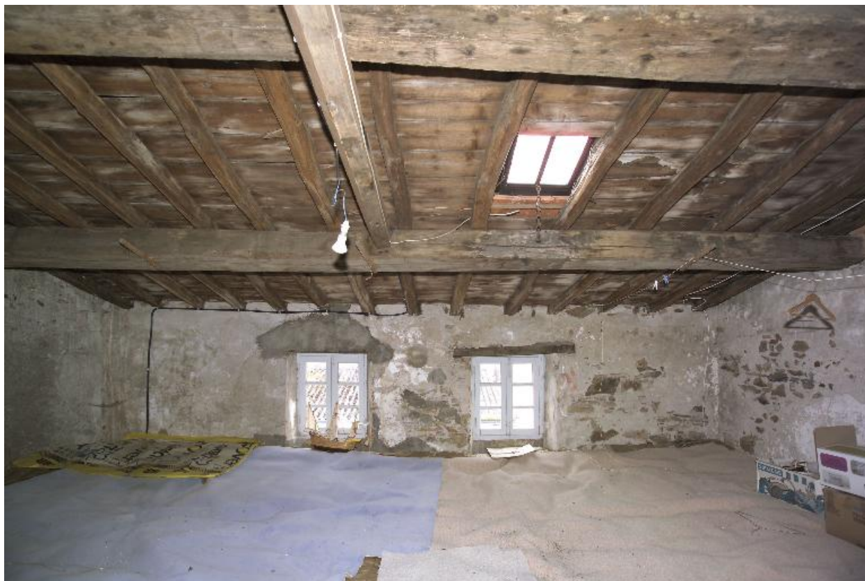
Le comble vu vers la rue.
