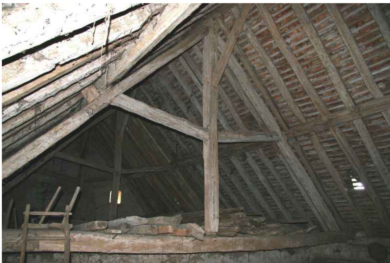
Ferme 1 : charpente à panne.
