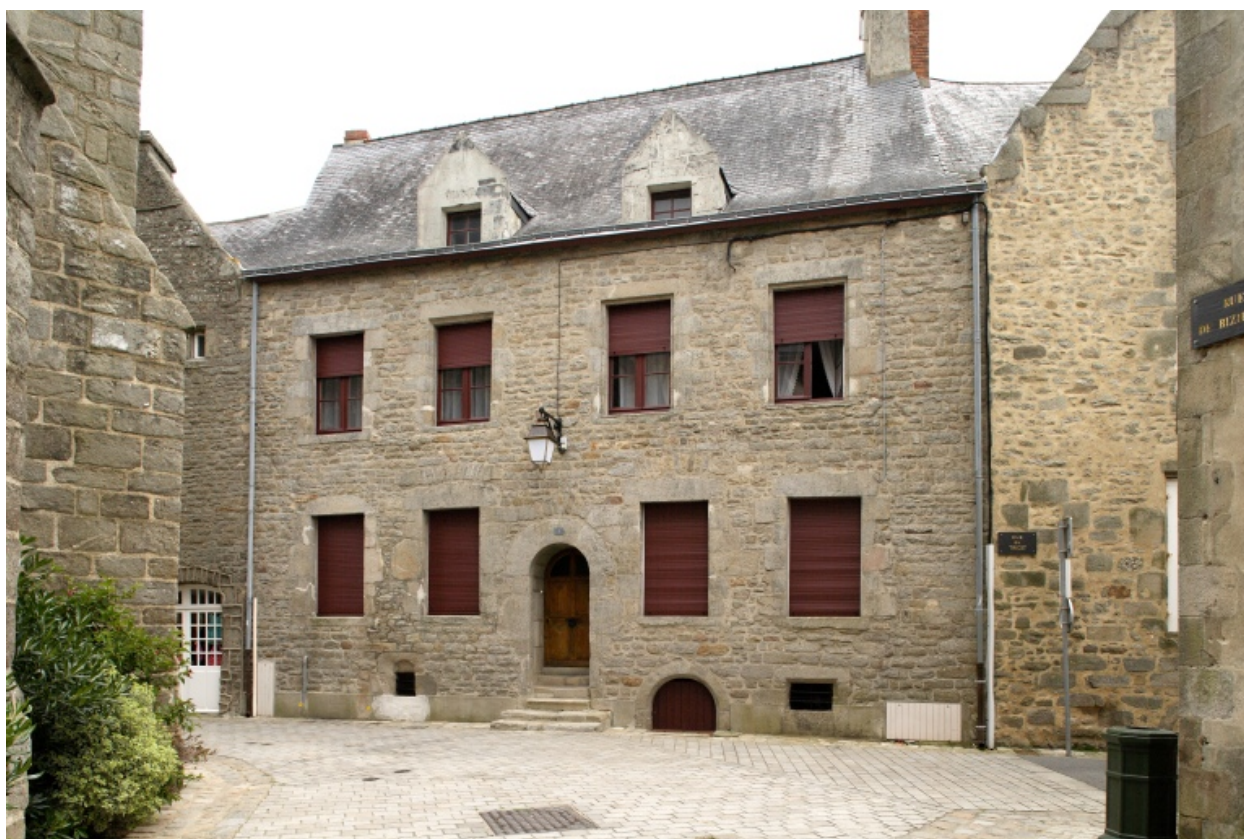
Vue de la façade sur rue.
