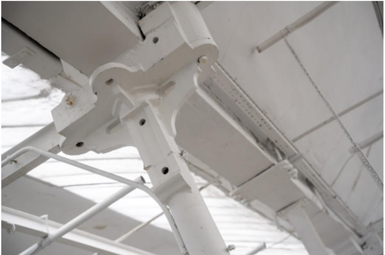
Détail charpente et colonne de l'atelier de fabrication A.
