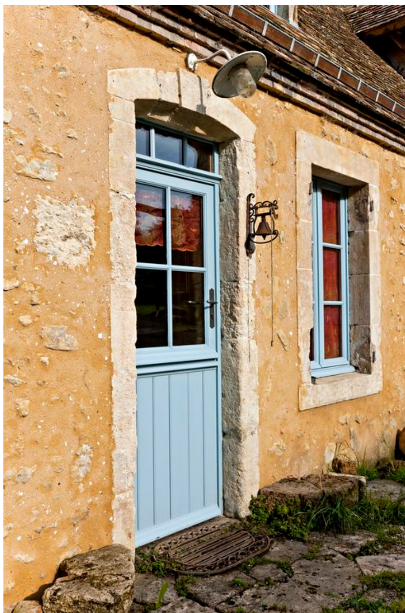
Baies de l'élévation sur cour du logis
