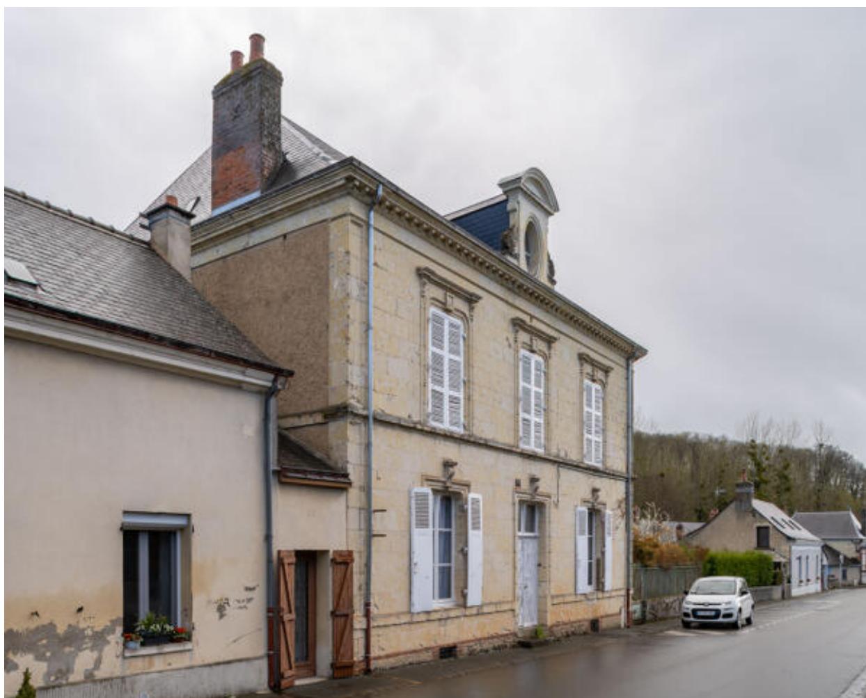
Vue d'ensemble depuis la rue.
