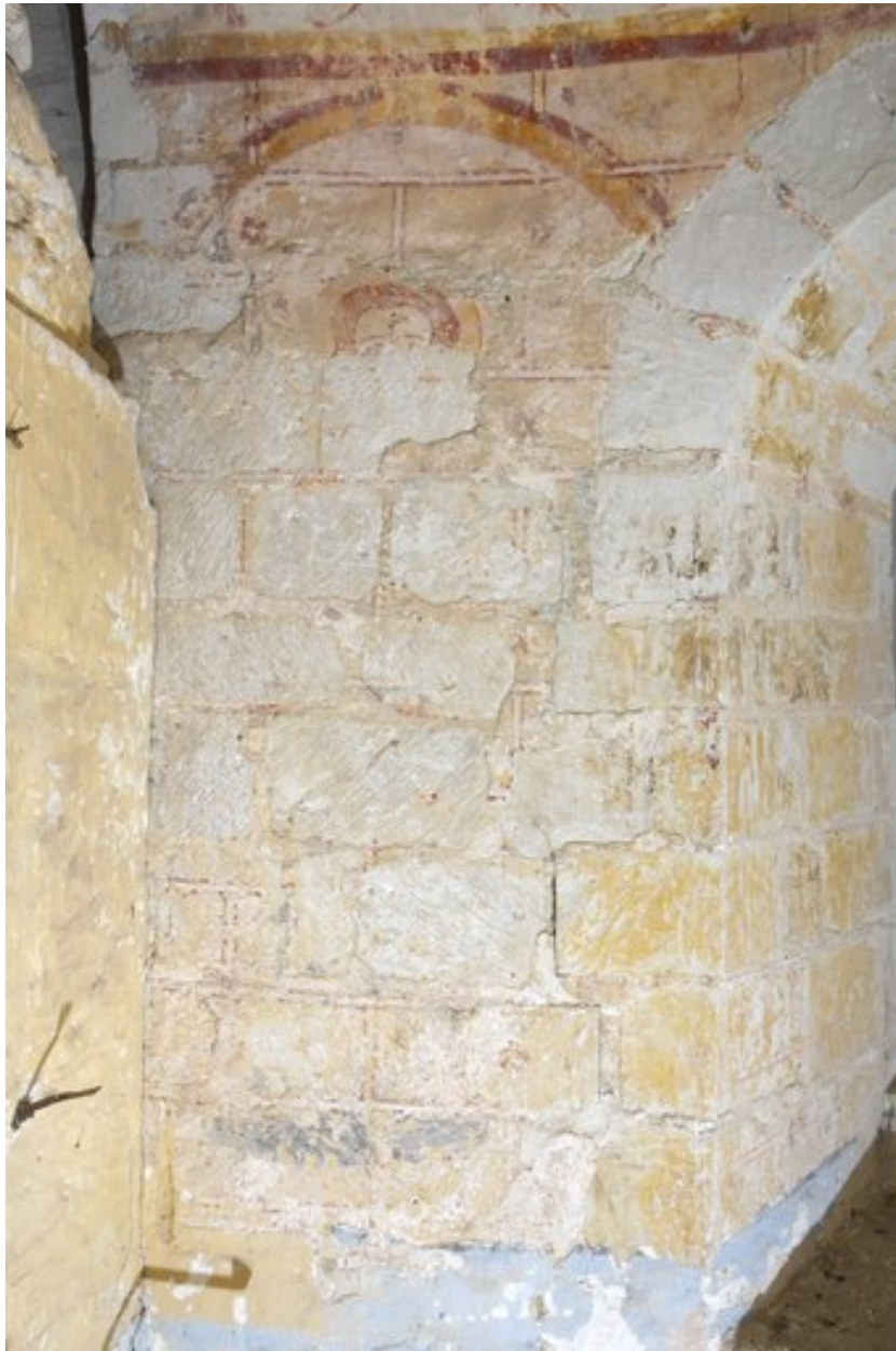
Choeur (sacristie), mur côté nord : apôtre placé sous une arcature et recouvrant un décor d'imitation de pierre de taille.
