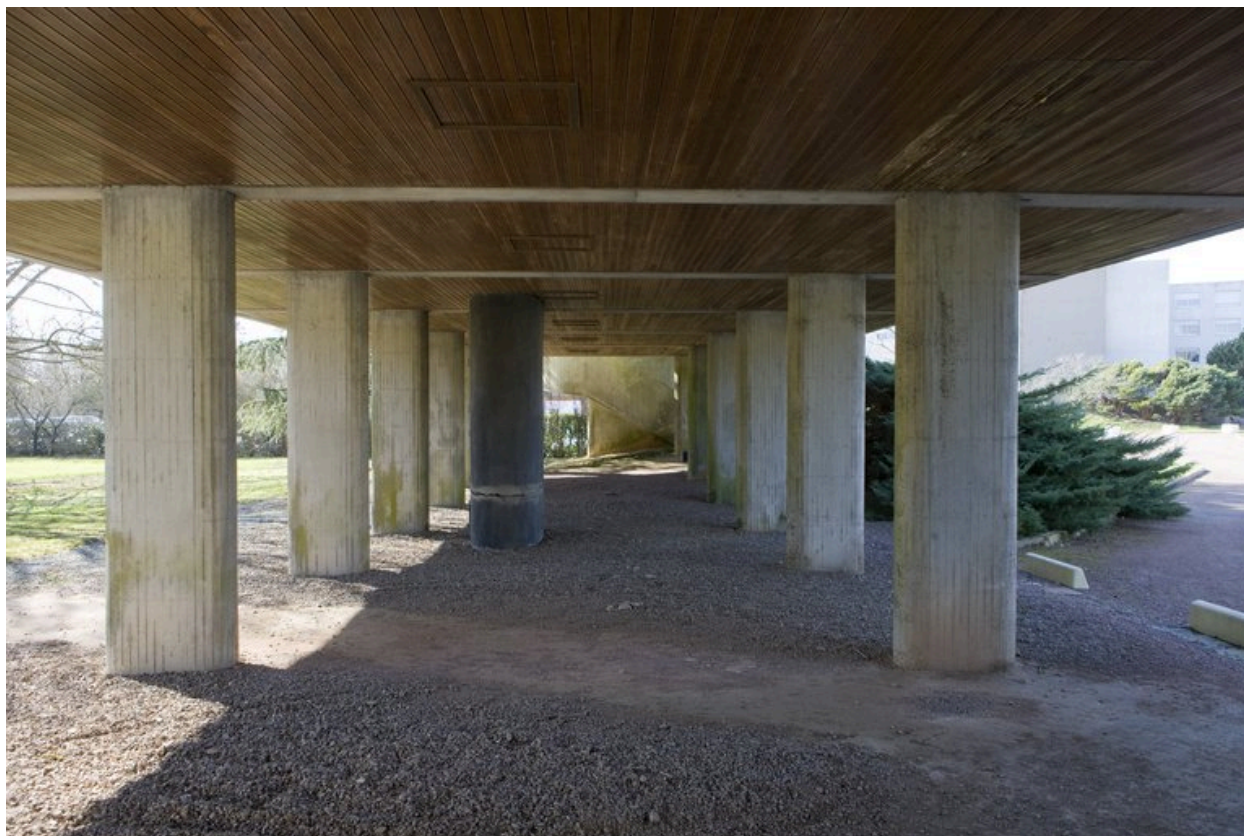
Vue des piliers sous la partie ouest.
