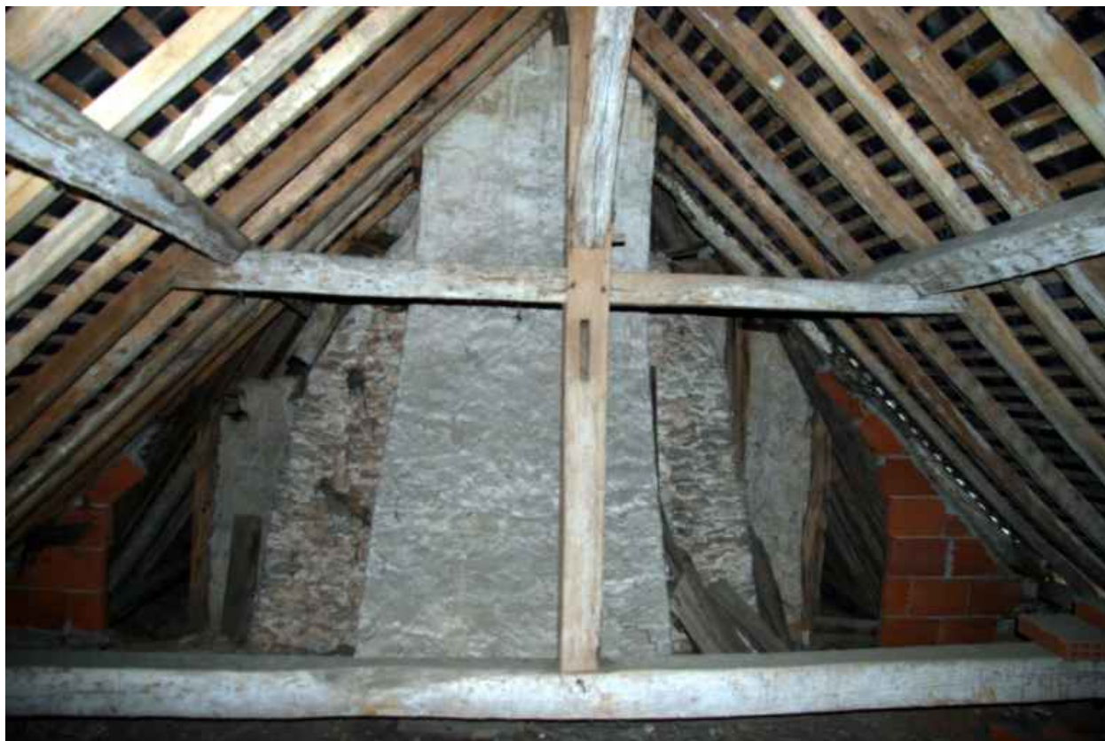
Travée gauche : charpente à pannes et encoches.
