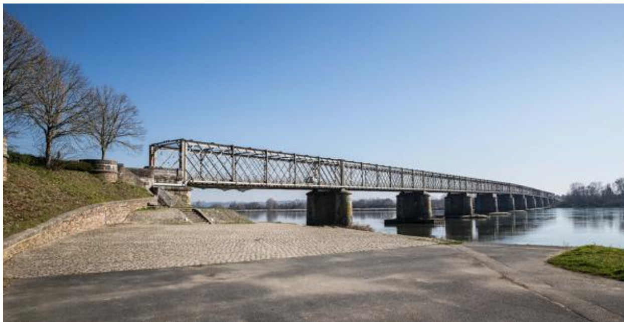
Vue générale depuis la rive nord.
