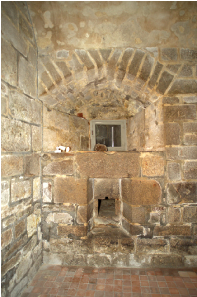
Ouverture de tir au rez-de-chaussée de la tour sud.
