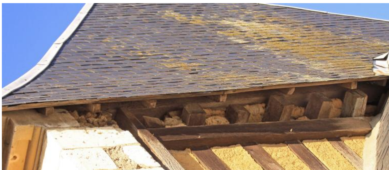
Pavillon, détail structure en bois sous la toiture.
