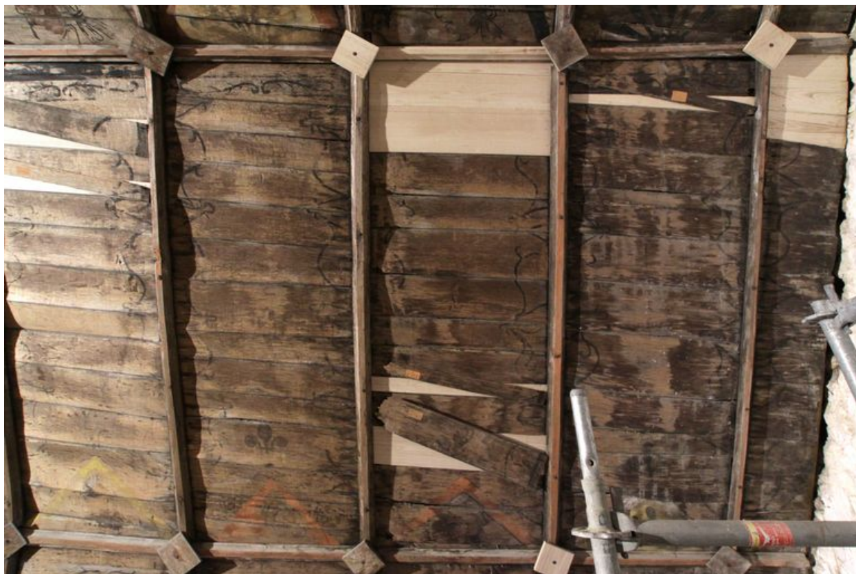
Nef, voûte lambrissée, côté sud, première travée : registre médian après les travaux effectués en 2010.
