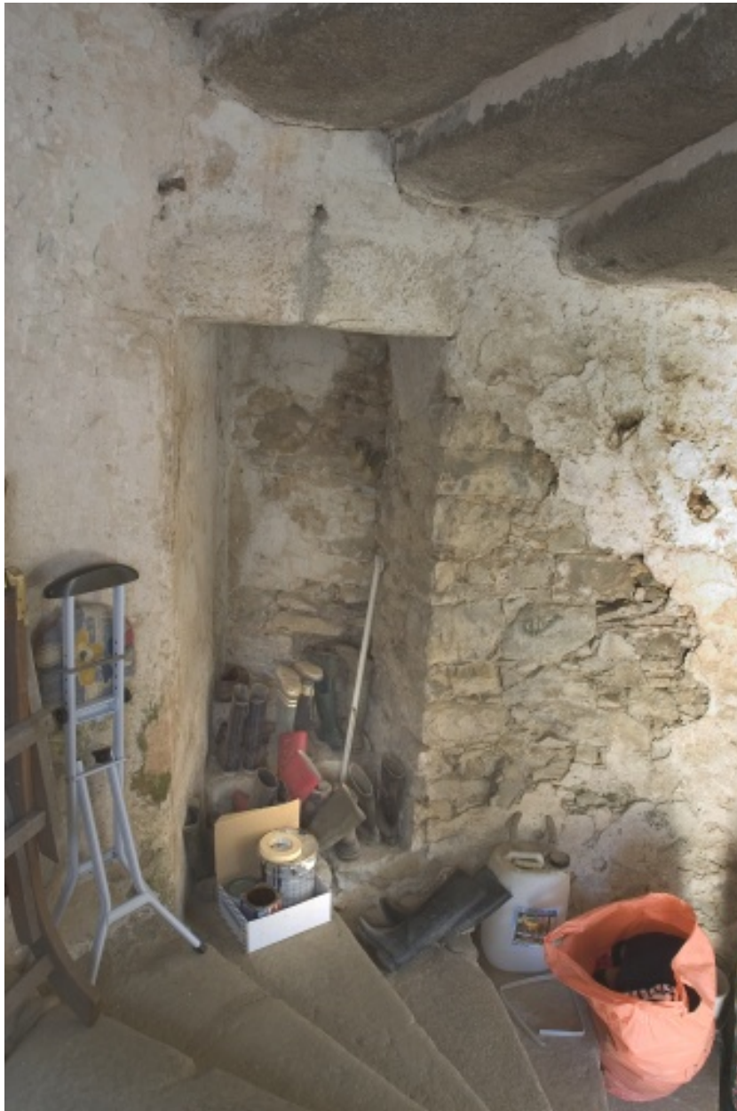
Intérieur du logis. L'escalier : porte d'accès à la chambre centrale du premier étage.
