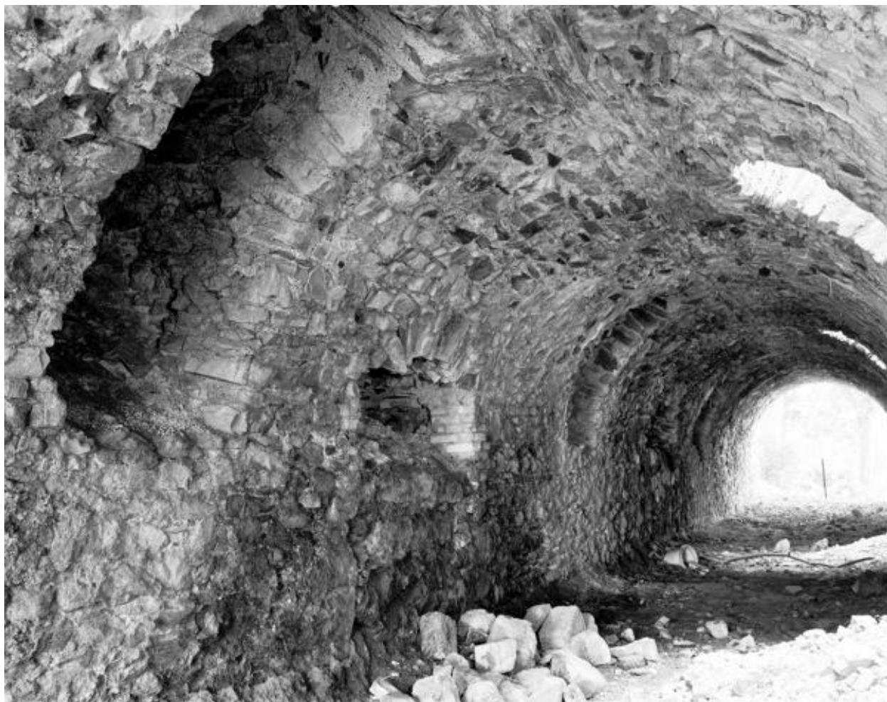
Vue d'ensemble d'est en ouest de la paroi sud-ouest de la grande galerie transversale du massif, fours à chaux de la Tranchée, Montjean-sur-Loire.
