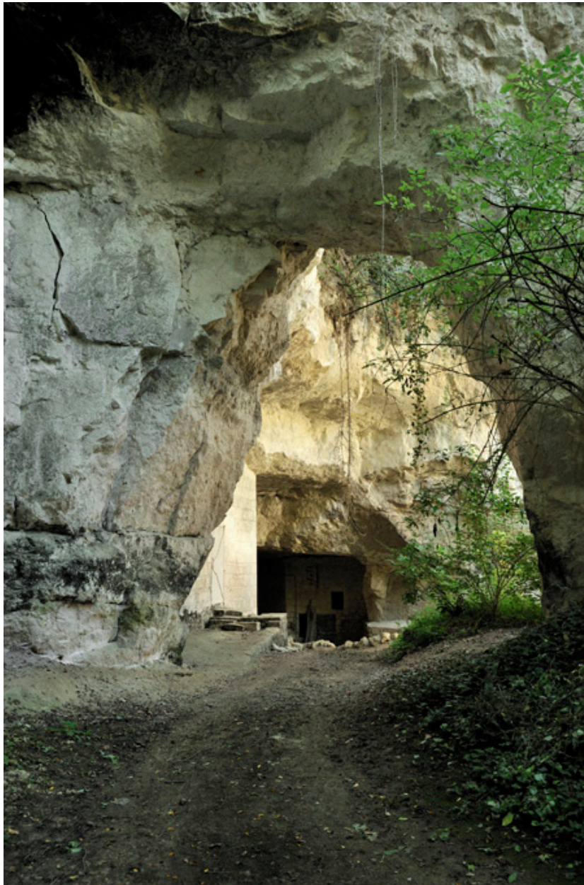
Site principal (11-16, ruelle des Perreyeurs). Fontis ouest. Arche.
