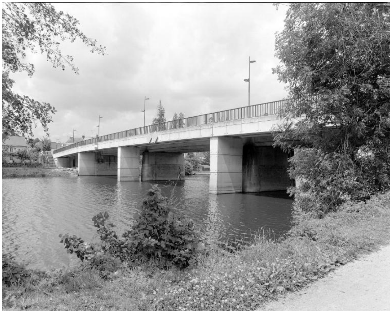
Vue depuis la rive gauche, en aval.
