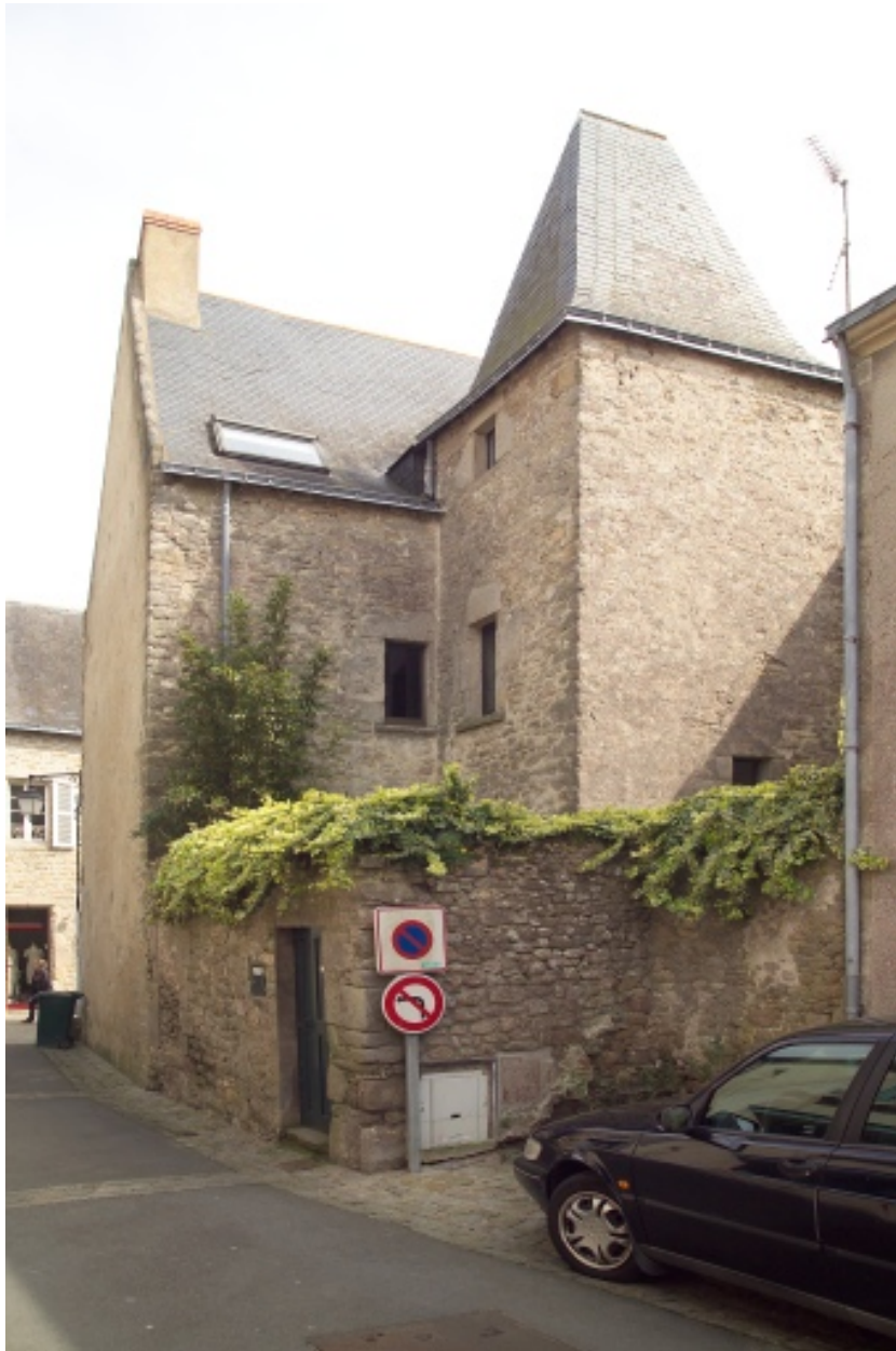
Façade postérieure et tour d'escalier.
