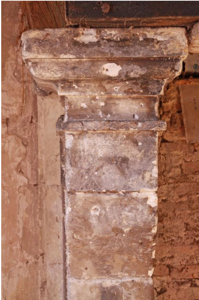
Pavillon, étage, cheminée : détail piédroit gauche.
