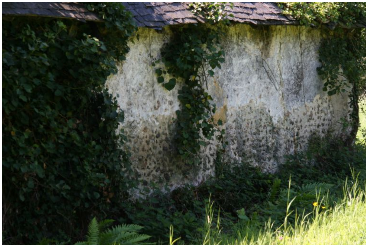
Façade postérieure : détail.
