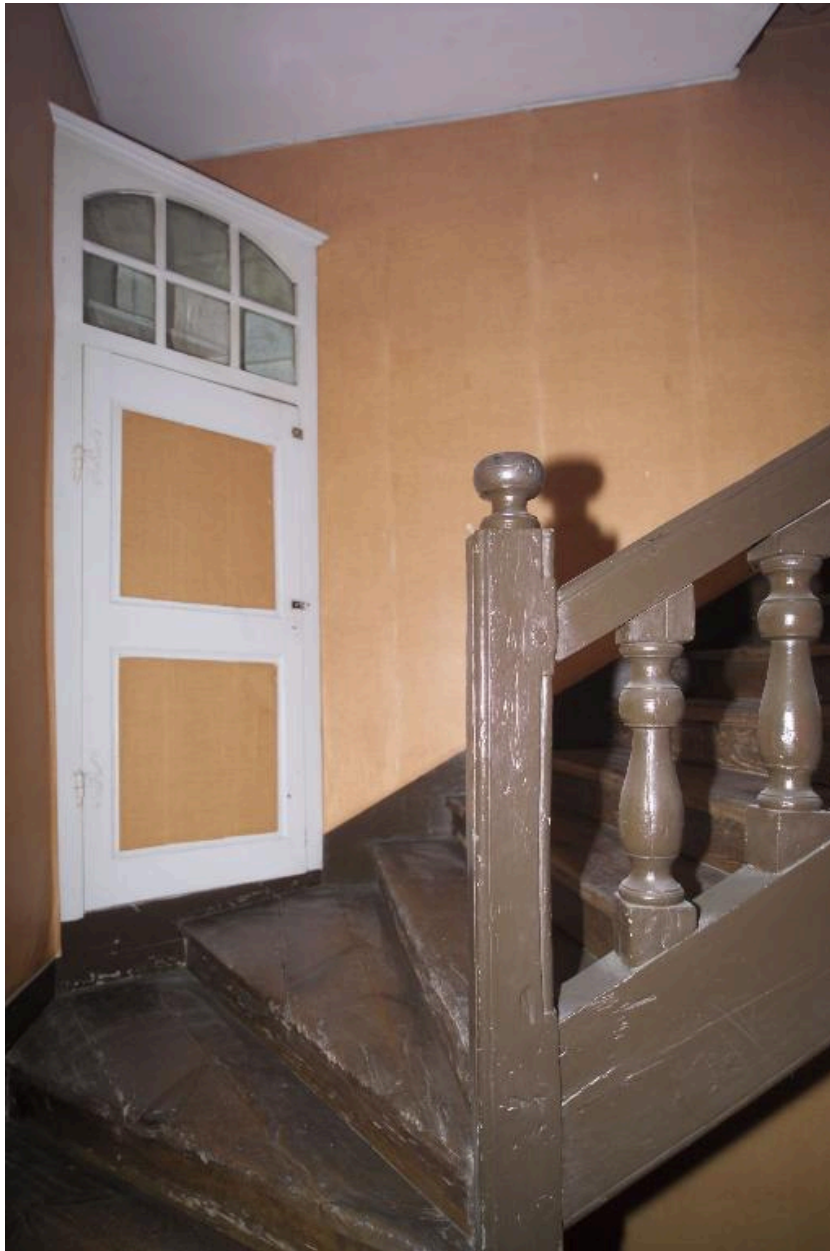
L'escalier, le placard situé entre le premier étage et l'étage de comble.
