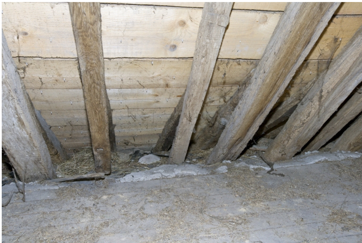
N° 10 rue Basse. Charpentes. Sablières.
