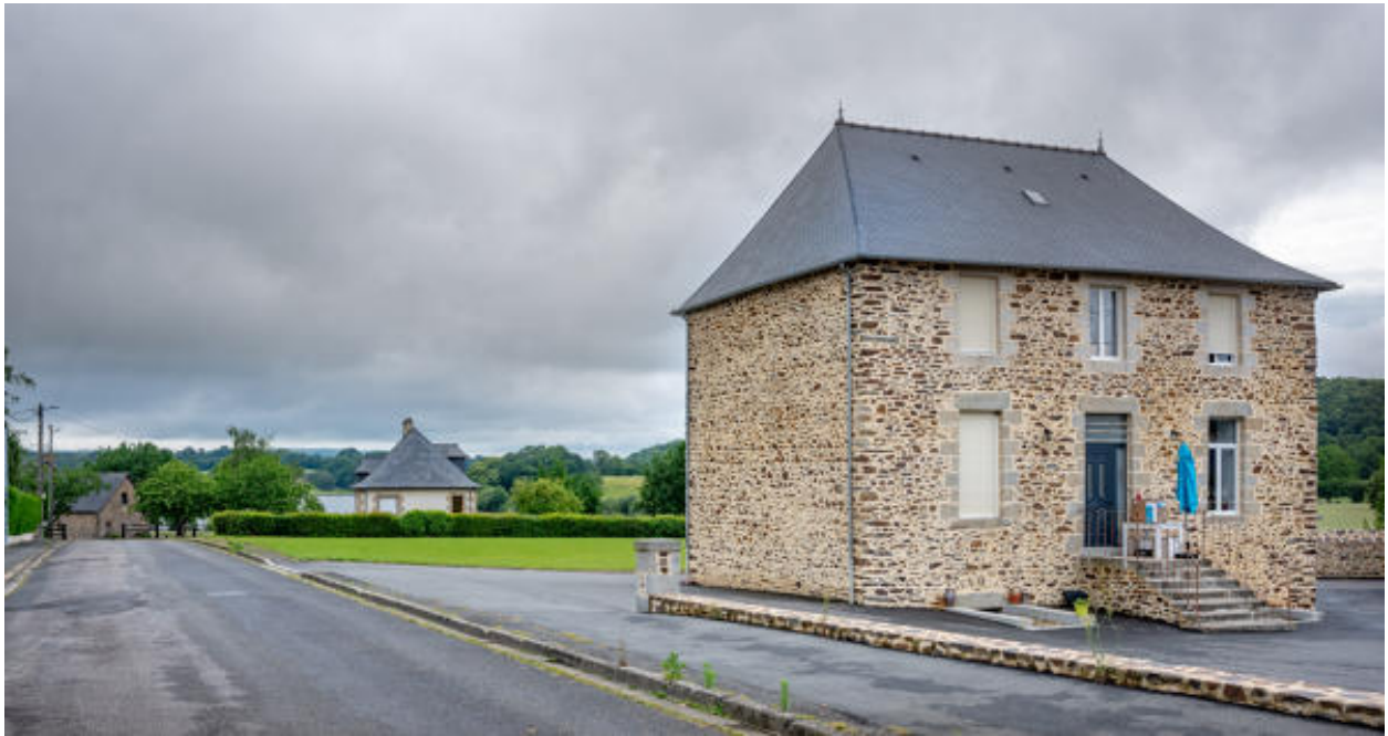
L'ancien presbytère, façade vers le bourg.
