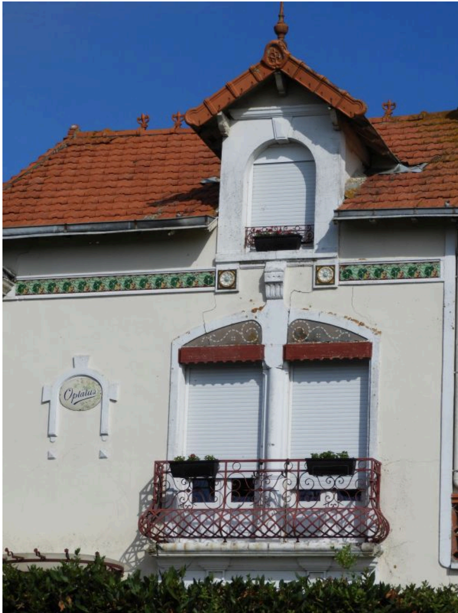
Détail de la façade : lucarne, baie jumelée, frise, cartouche.
