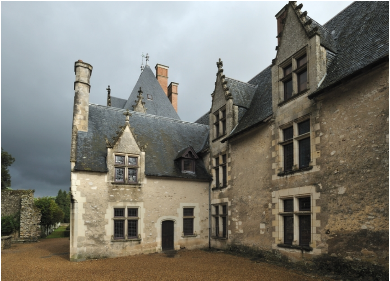
Logis : aile basse en retour d'équerre et façade ouest du corps principal (photo 45).
