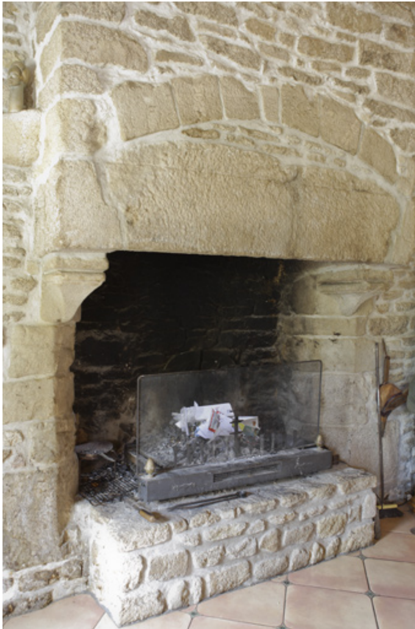
Logis. Vue de la cheminée du rez-de-chaussée.
