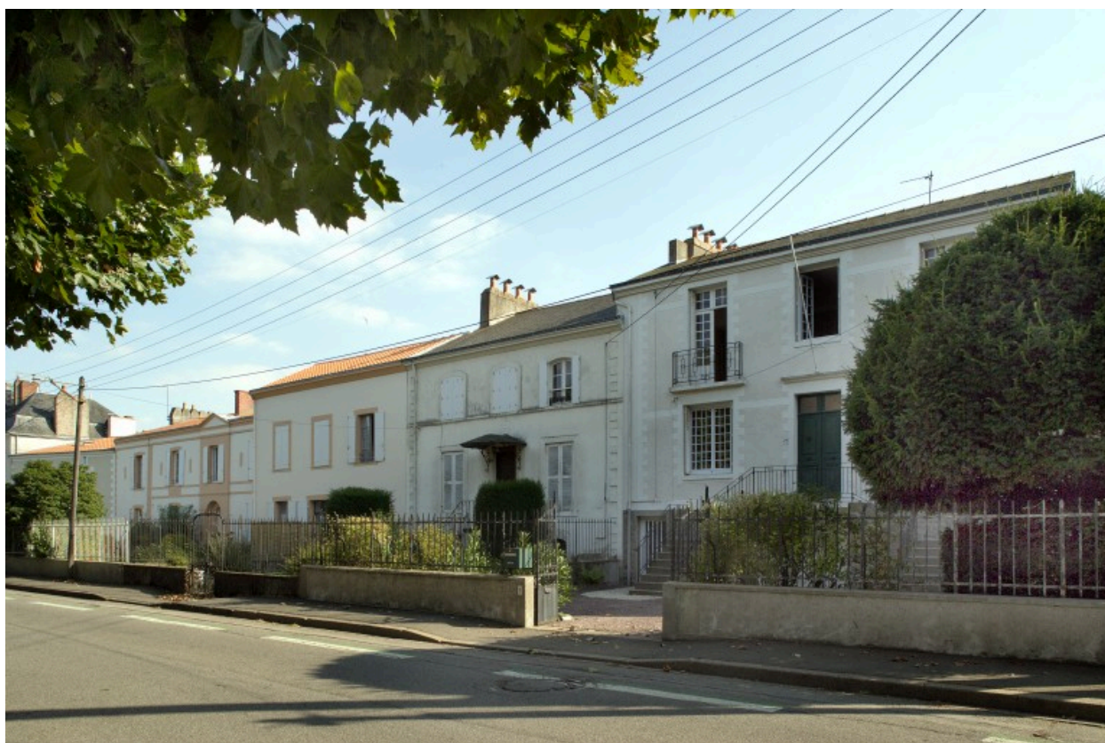
Vue d'ensemble du n° 7 au n° 9, quai Eole.
