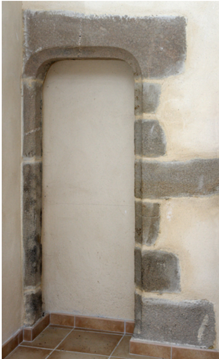
Logis. 1er niveau. Salle ouest. Porte sur le pignon ouest.
