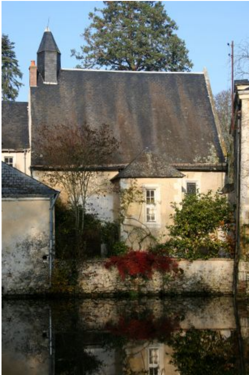
La chapelle : façade méridionale.
