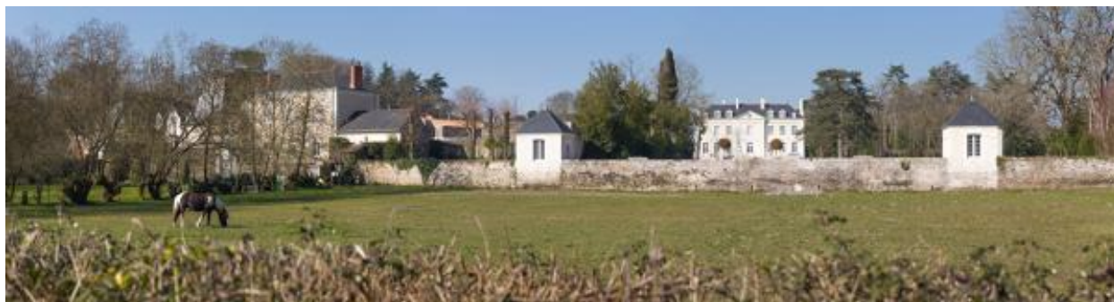
Vue panoramique depuis le sud.
