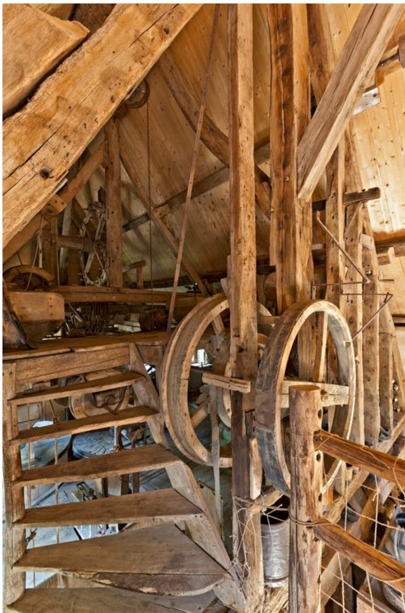
Escalier d'accès à l'étage de comble
