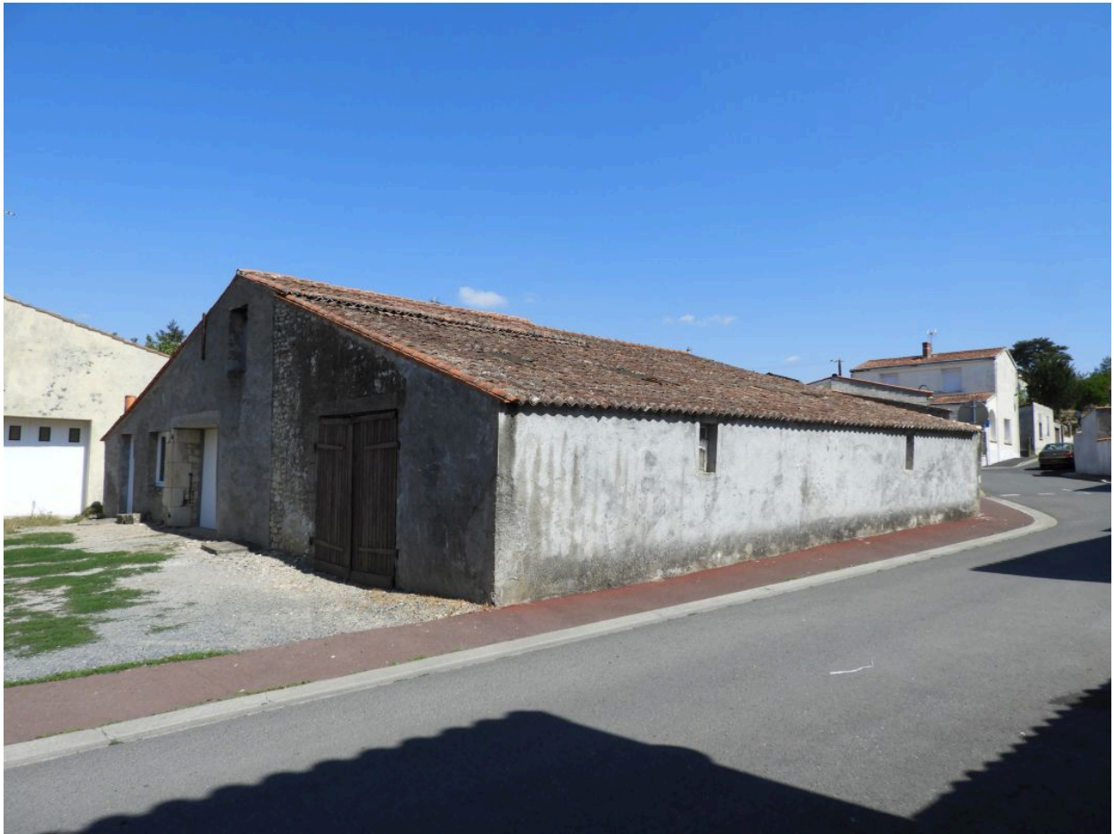
L'ancien chai vu depuis le sud-ouest.
