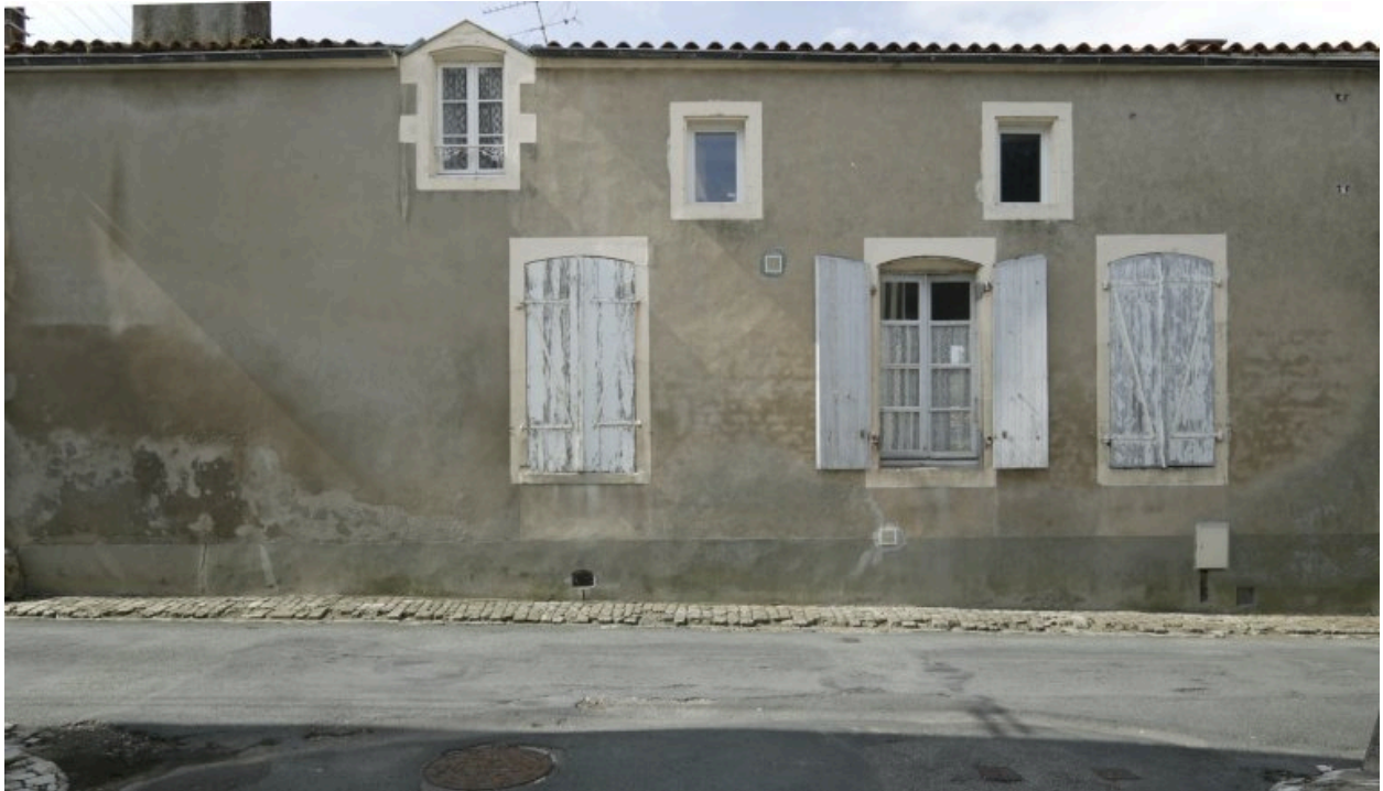
Façade latérale, rue du Grand-Carmel.
