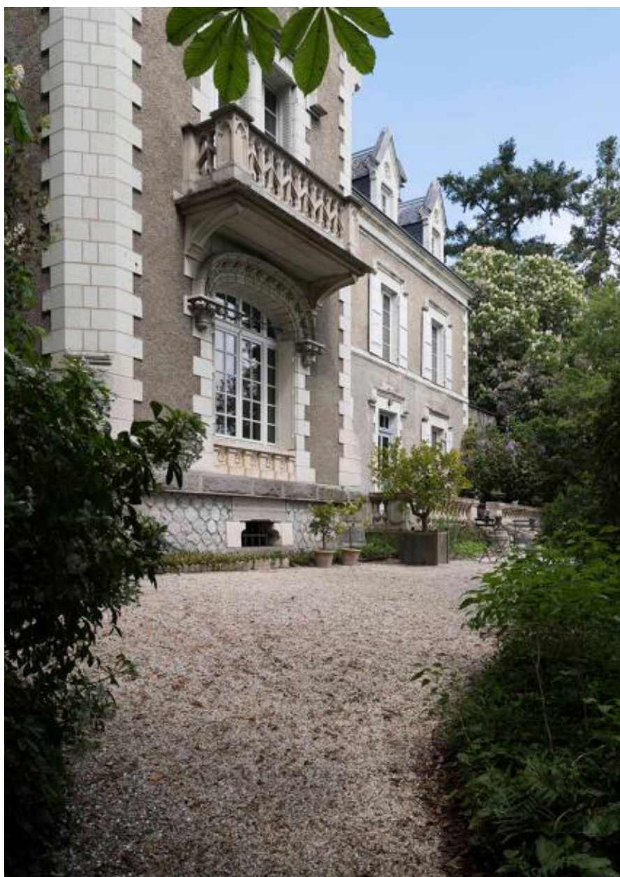
Détail de la façade est.
