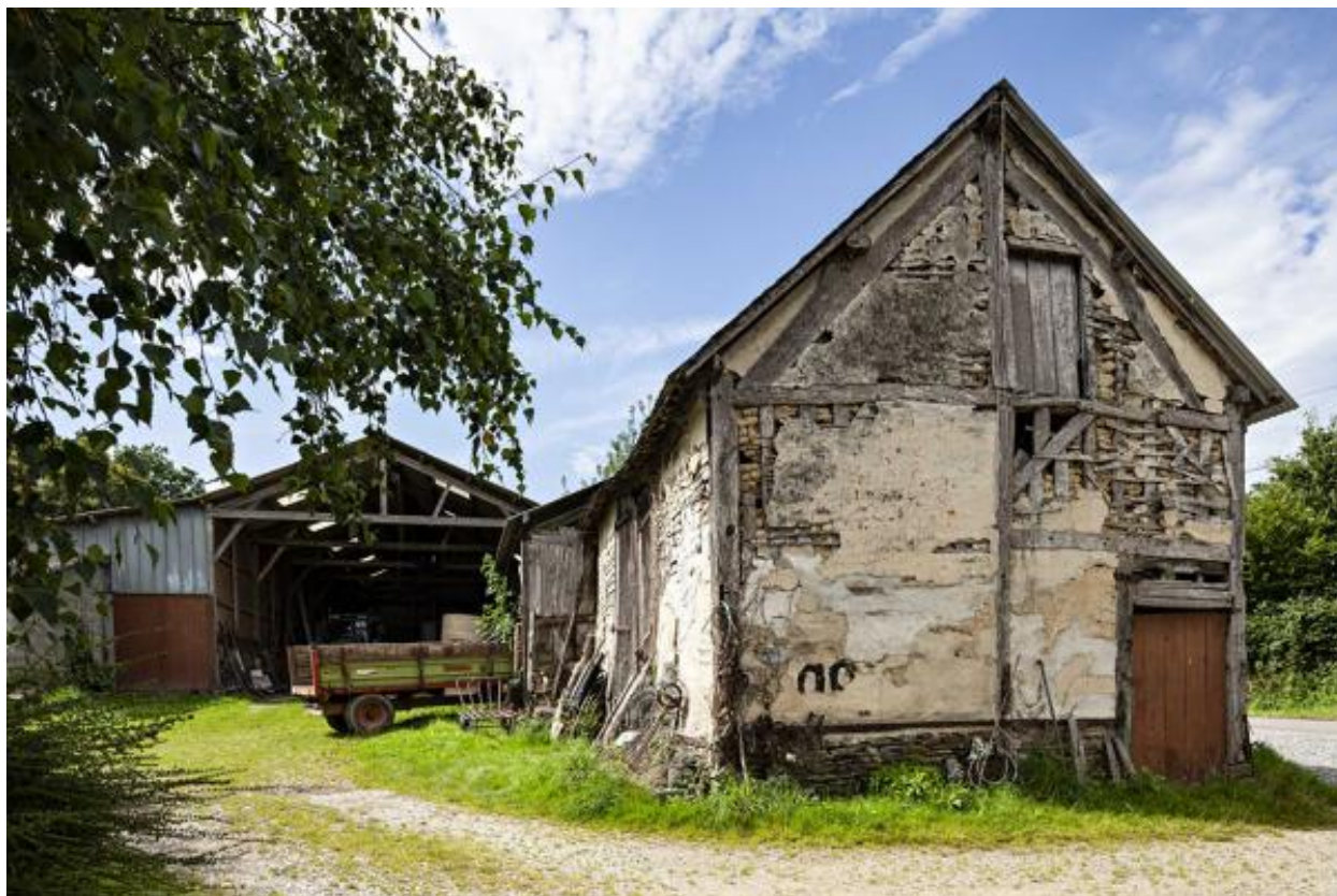
Remise en pan de bois, sud du hameau.
