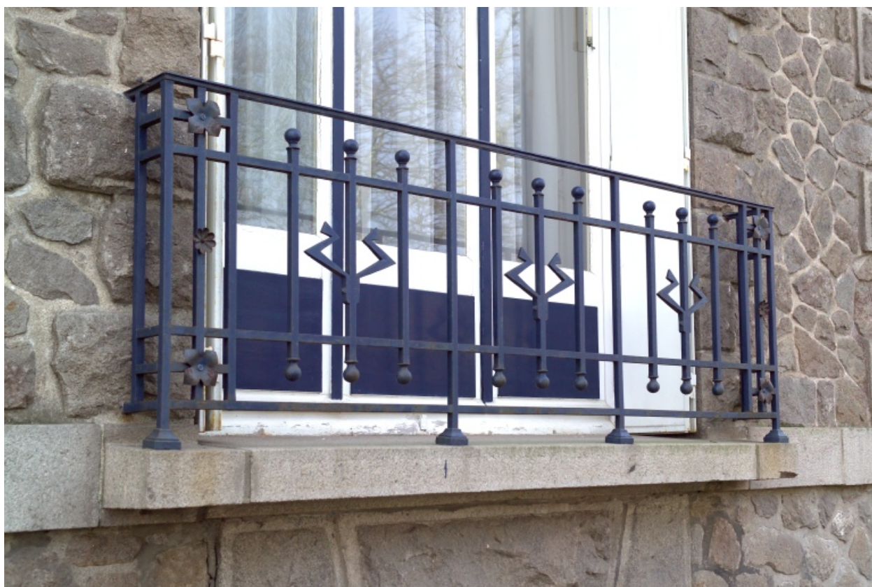
Détail des feronneries d'une fenêtre de rez-de-chaussée.
