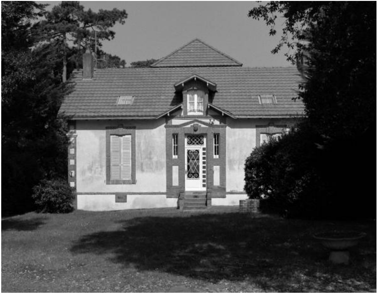
Villa le Vallon, élévation sud-est sur rue.
