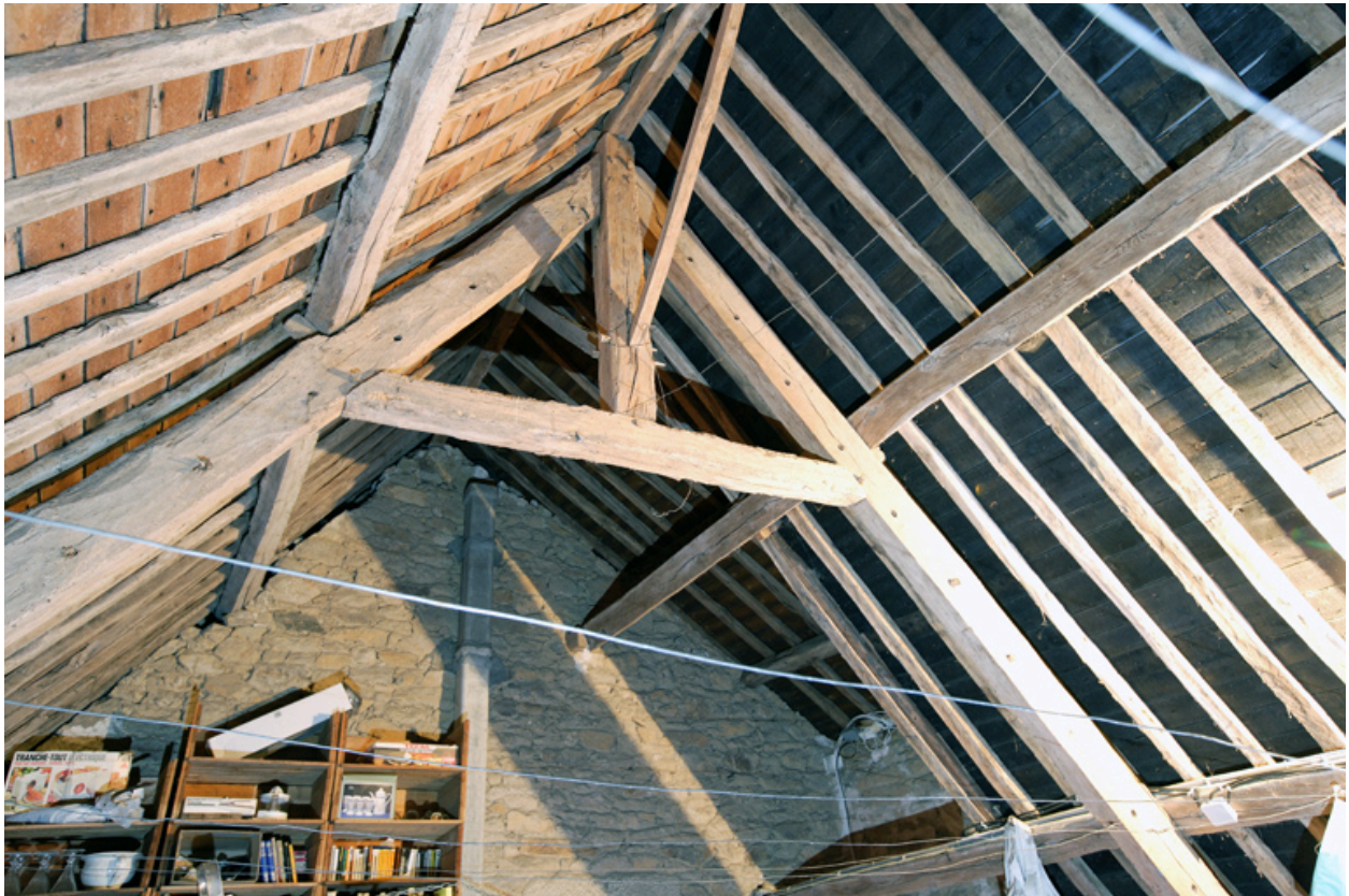
Logis. Comble. Vue de la charpente.
