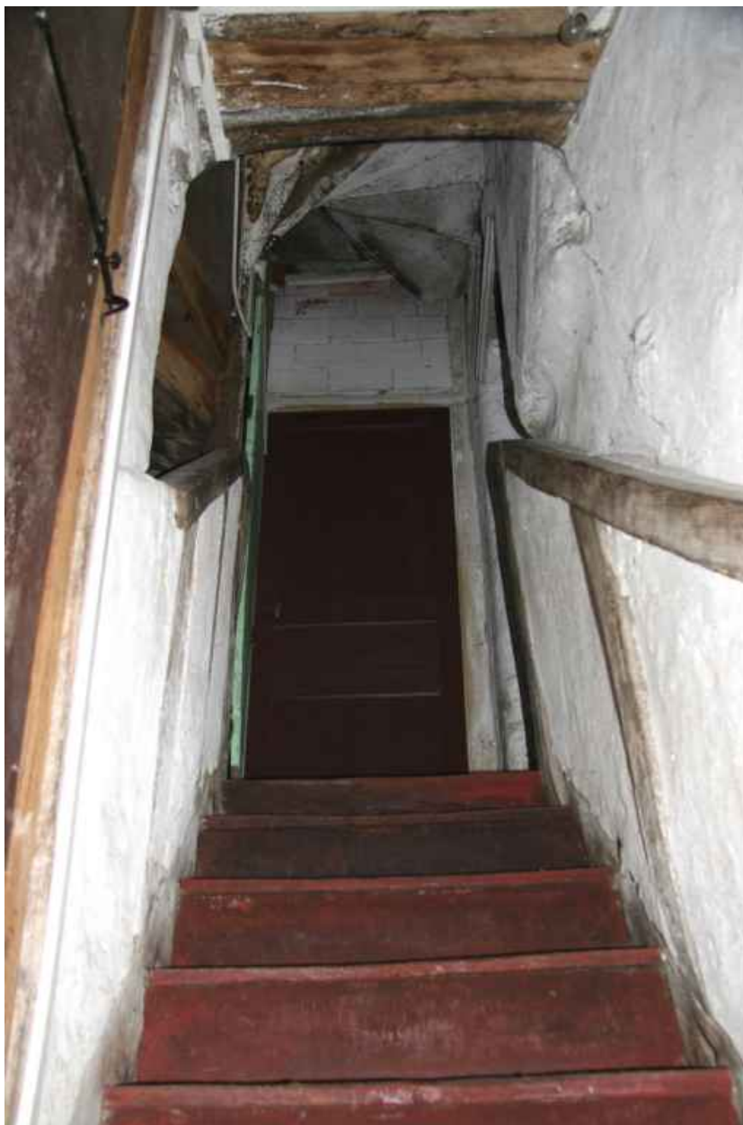
Escalier hors œuvre droit depuis la cour.
