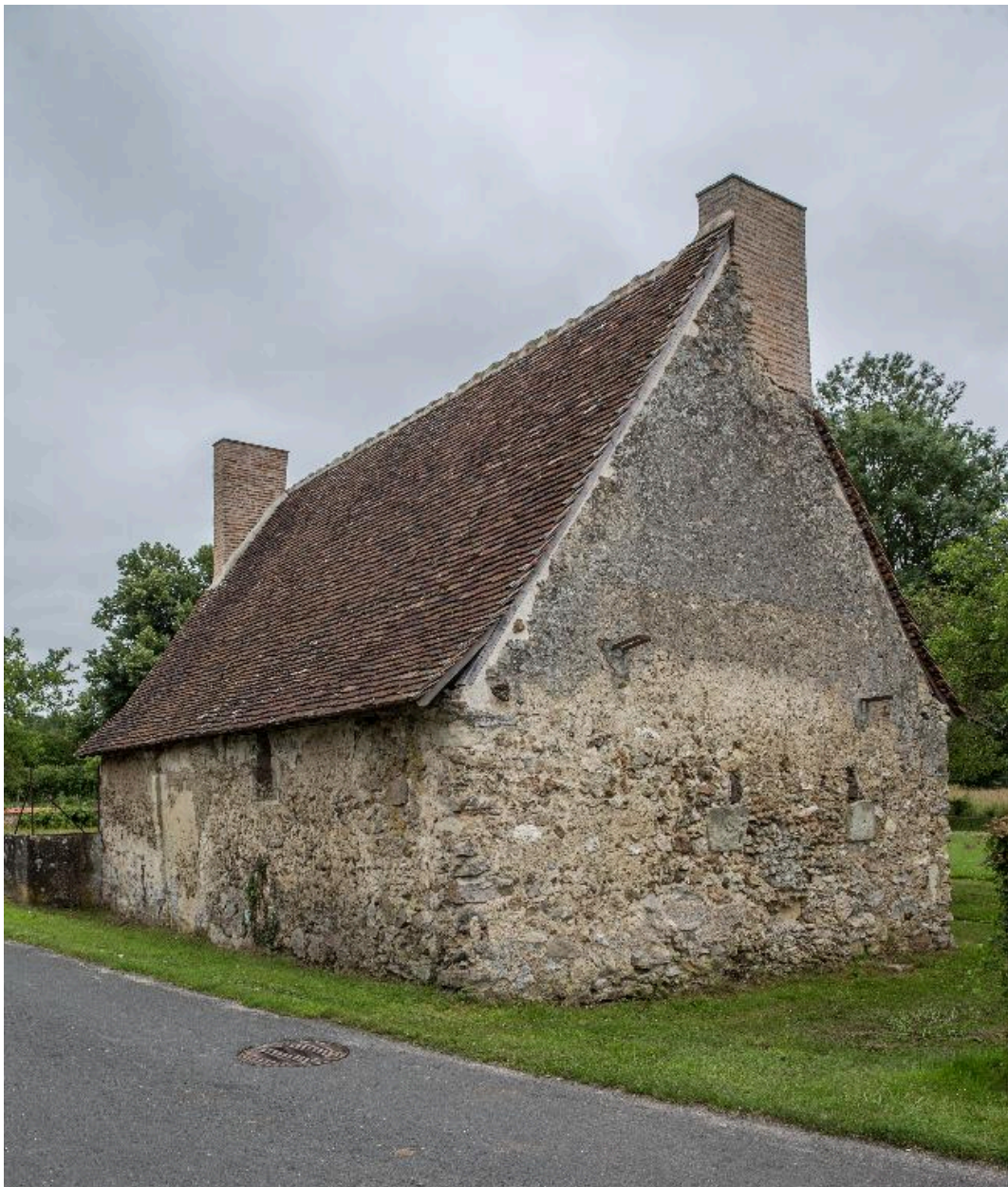
Vue de volume (façades nord et ouest).
