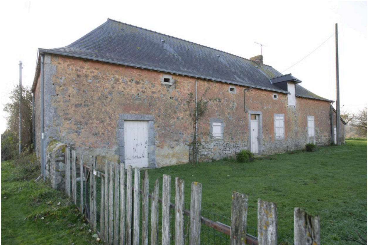
Le logis vu depuis le nord-est.
