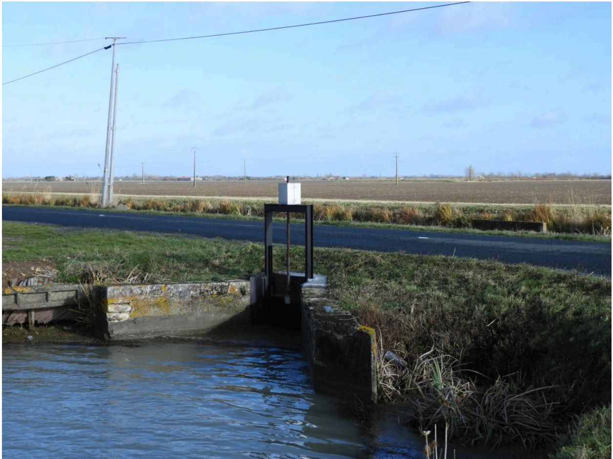
Vanne métallique à la cabane des Bardettes, à Sainte-Radégonde-des-Noyers, sur la rive droite du canal du Clain.
