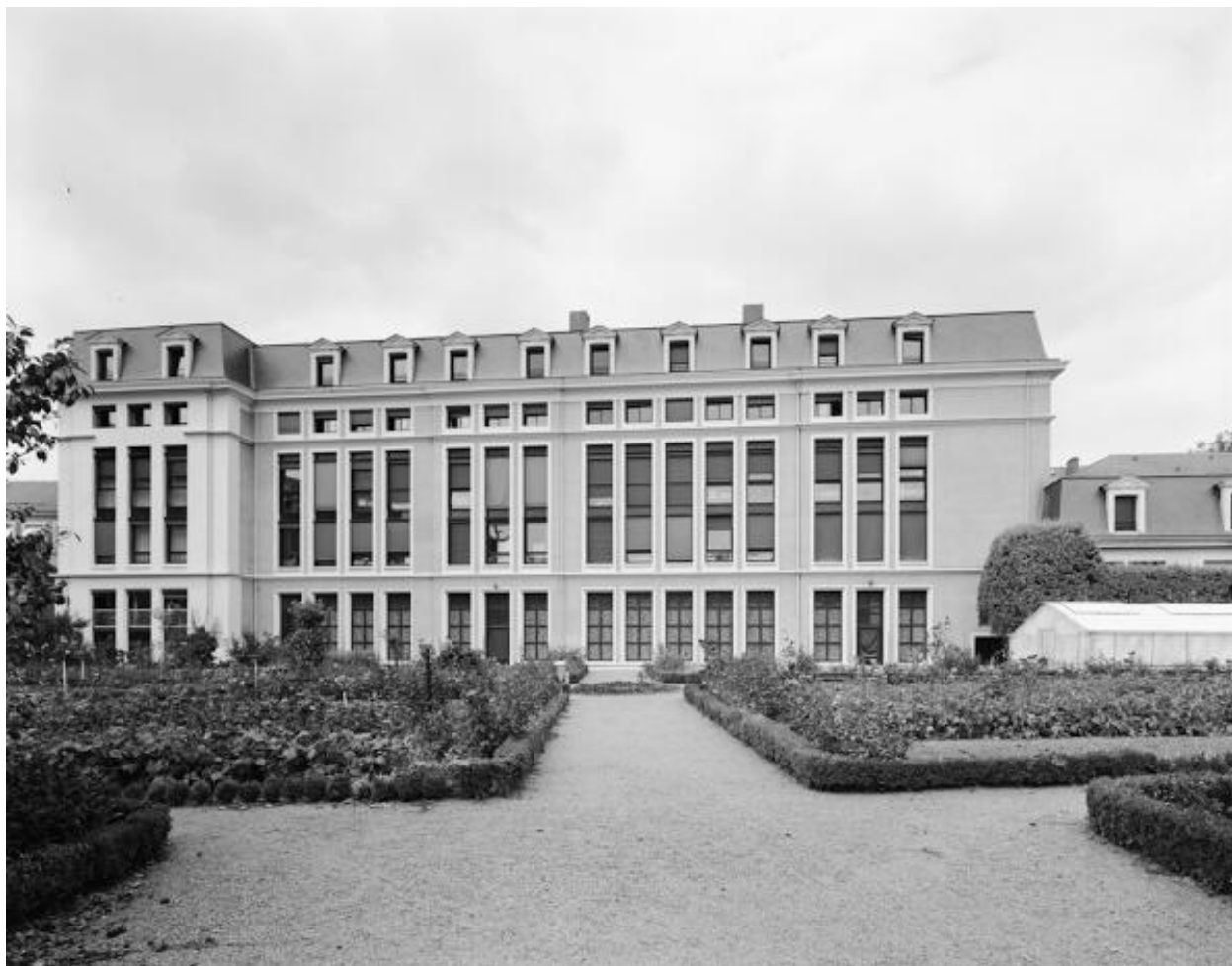
Bâtiment principal des Archives : élévation sud, sur le jardin-potager.
