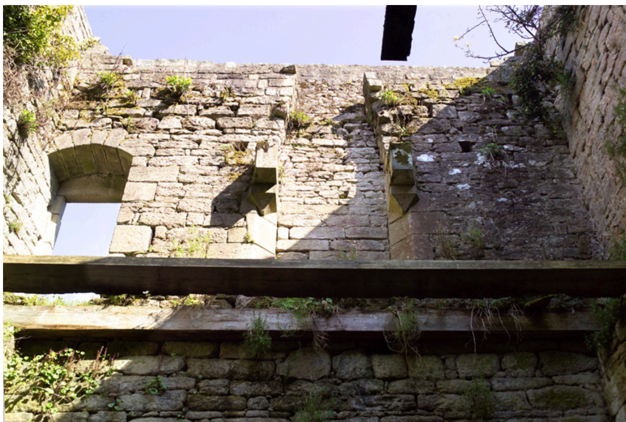
Parement interne du mur est, premier étage.
